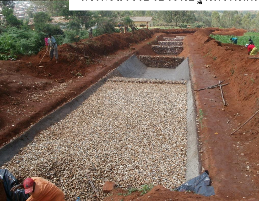
การก่อสร้างบึงประดิษฐ์ที่น้ำไหลใต้ผิวชั้นกรอง (Subsurface Flow Systems)
